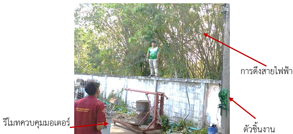
ภาพที่ 3 การใช้งานอุปกรณ์ช่วยดึงสายไฟฟ้าแรงต่ำ
