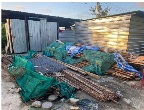
ภาพที่ 6 กองเหล็กบริเวณสถานที่ก่อสร้าง
