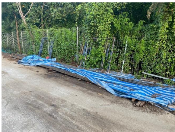
ภาพที่ 7. กองเหล็กในพื้นที่ก่อสร้าง
