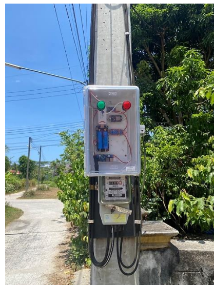
ภาพที่ 3 การติดตั้งบนเสาไฟฟ้าสายส่งแรงต่ำผ่านแอปพลิเคชัน
